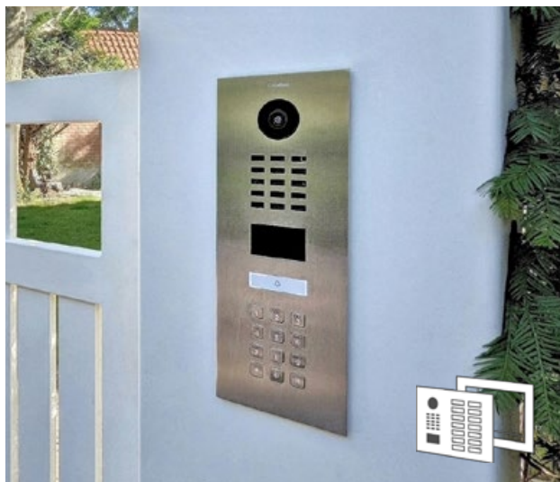
Montaggio sotto intonaco
